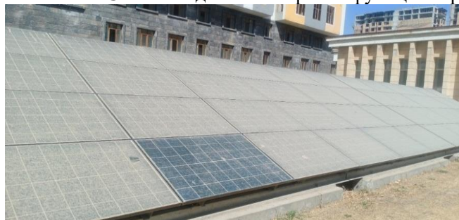
Рисунок 3. Осаждённая пыль на поверхности фотоэлектрических панелей Солнечной фотоэлектрической станции мощностью 40 кВт Научно-исследовательского института акушерства, гинекологии и перинатологии Таджикистана.
